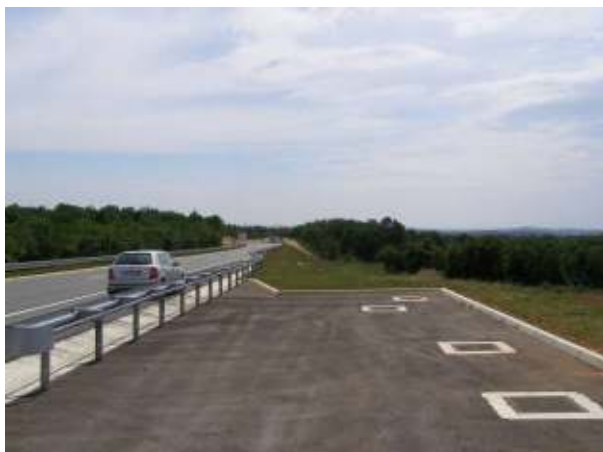
Slika 2 Separator otpadnih voda uz autocestu
