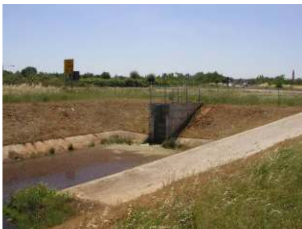
Slika 1 Laguna za pročišćavanje otpadnih voda
